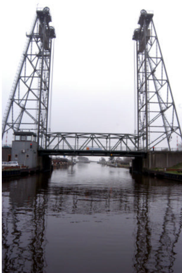
Foto: Hefbrug Gouwsluis met op de achtergrond de spoorbrug over de Gouwe.
