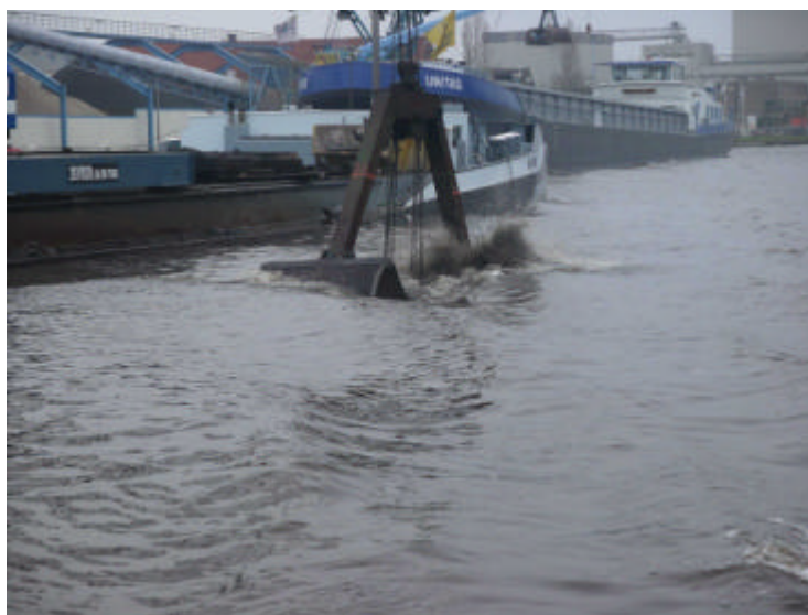
Foto: Kraanschip, meest gebruikelijke methode van baggeren
