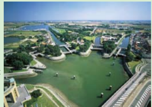
het sluisencomplex Ganzepoot te Nieuwpoort
