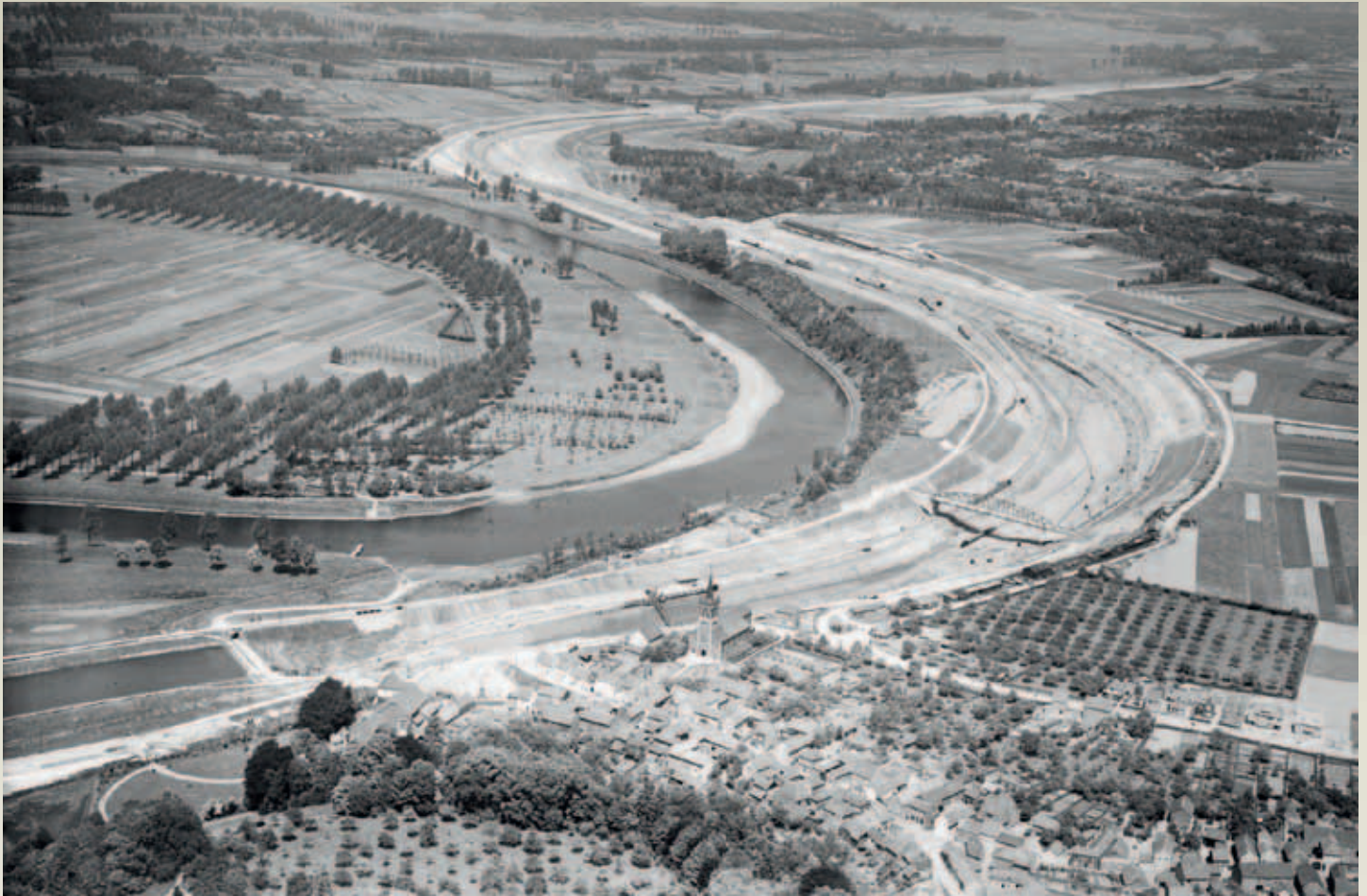
Werkzaamheden bij Elsloo uit de lucht; 1933 (Bron: Streekmuseum Elsloo)
