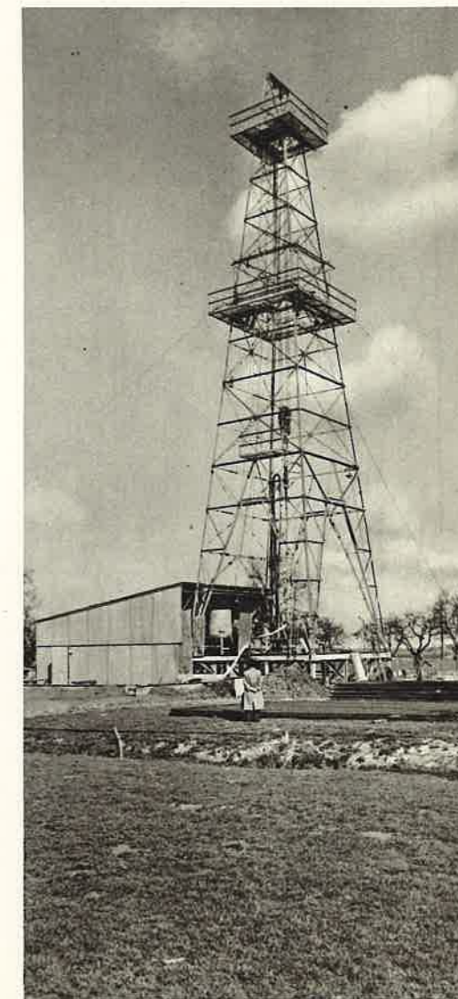
Fig. 283. Onderzoekingsboring in Holland met Conrad-Stork boormateriaal
