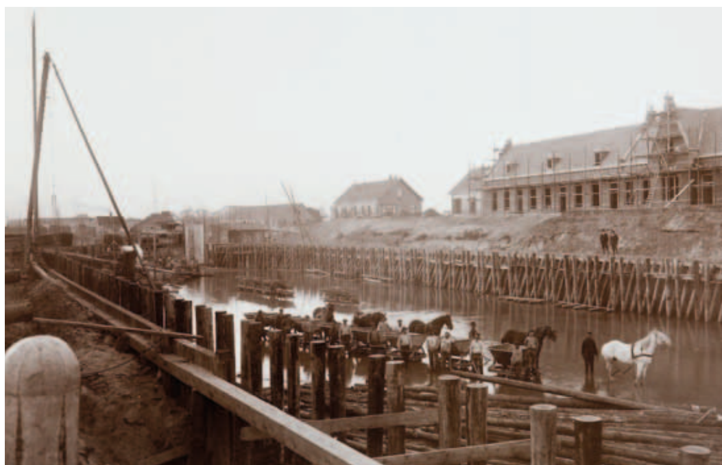
In 1904 wordt er bij Utrecht een tweede schutsluis in het Merwedekanaal aangelegd
